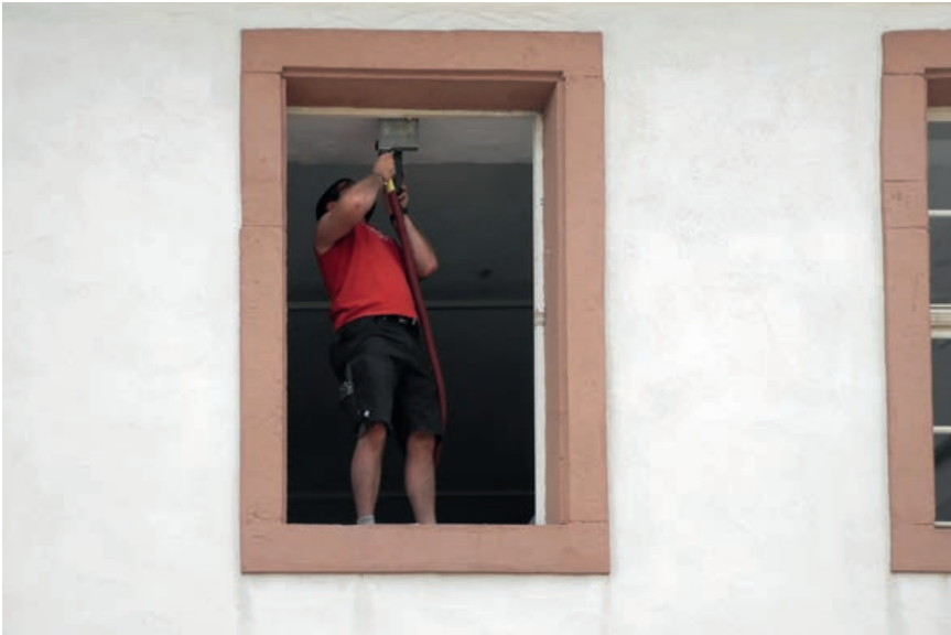
Beispiel laufende Sanierungsmaßnahme
