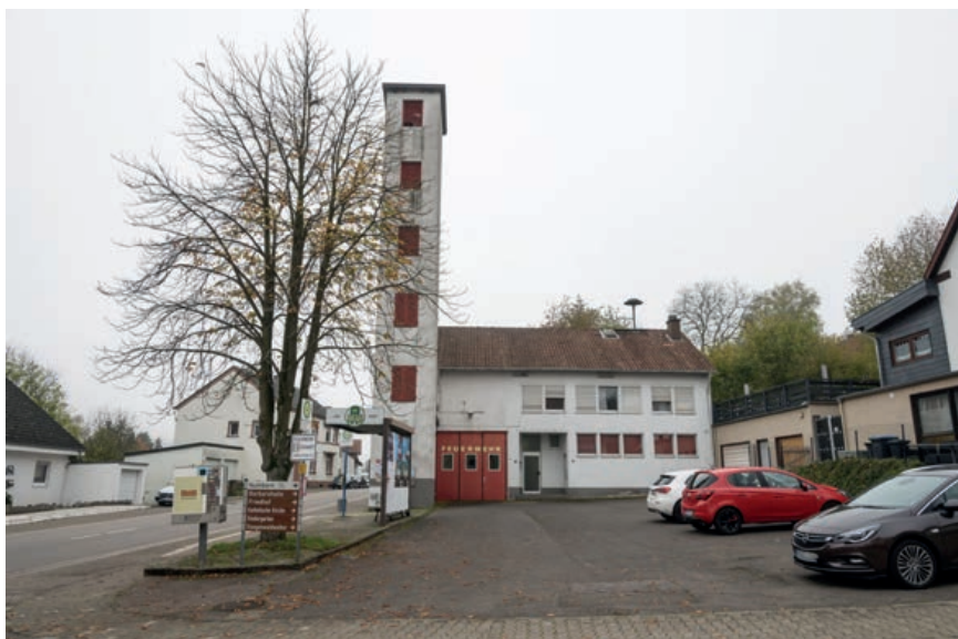
Vorfläche der alten Feuerwehr mit Aufwertungs-/ Umnutzungsbedarf
