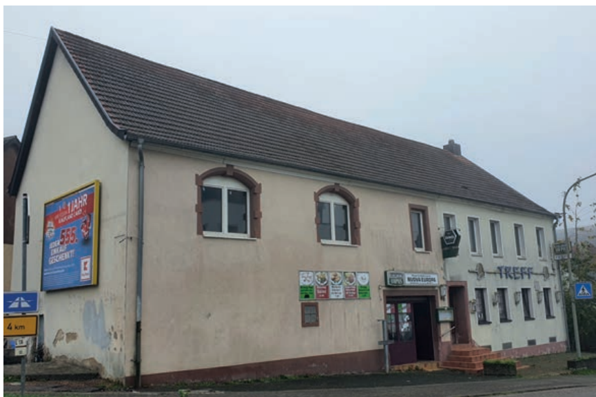
Ortsbildbeeinträchtigendes Gebäude in der Heusweiler Straße
