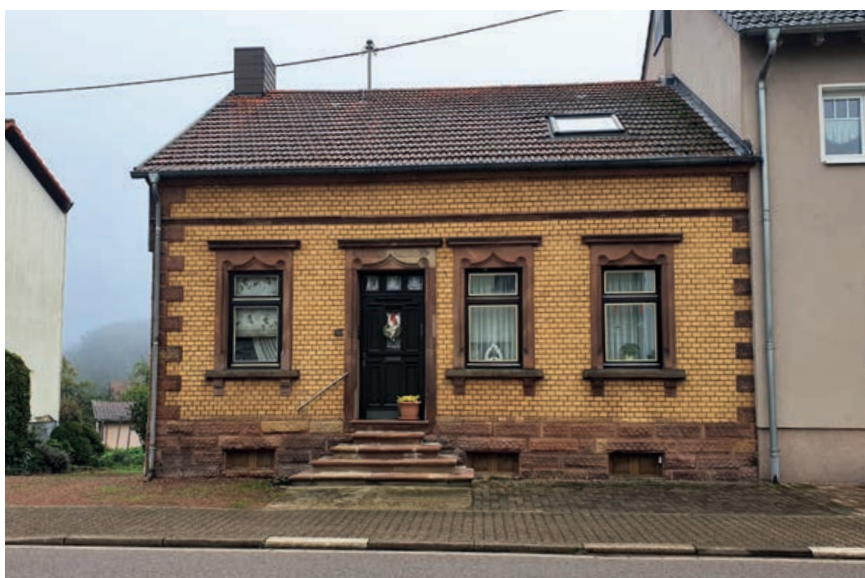
Arbeiterhaus in der Heusweilerstraße
