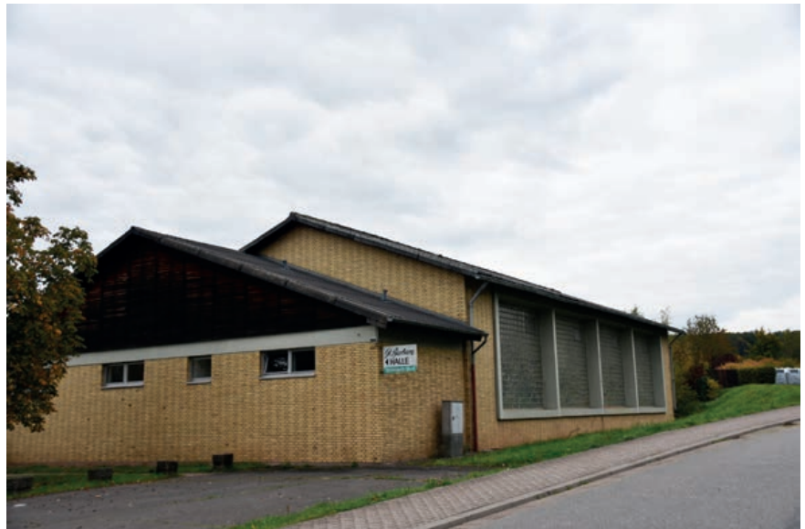
Barbarahalle vor Modernisierung
