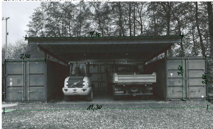
Quelle: Bauunternehmung Pischke
