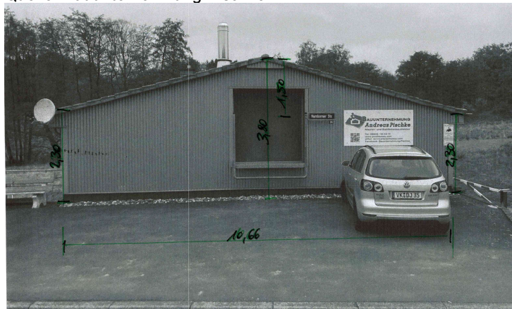
Quelle: Bauunternehmung Pischke
