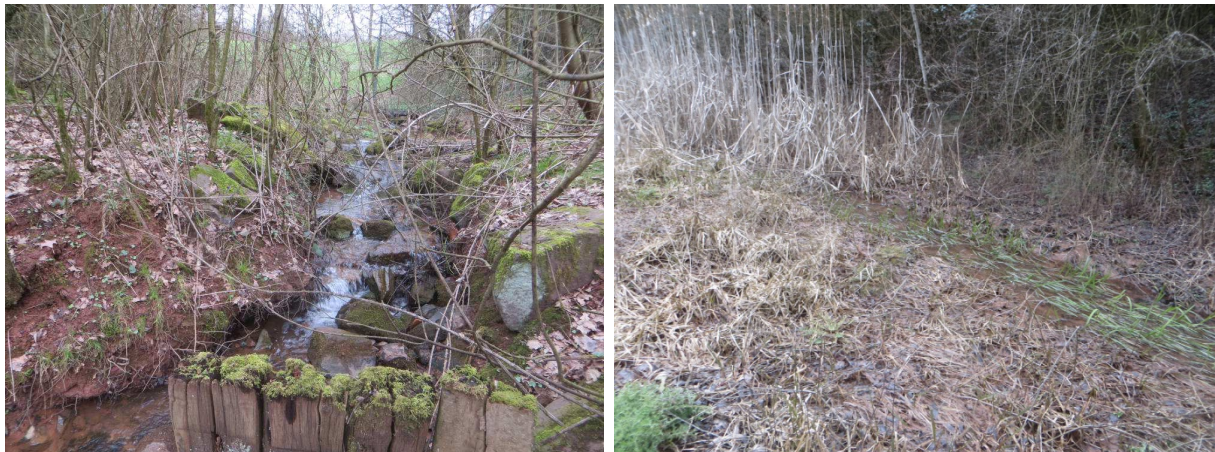
Abb. 12: mit Wasserbausteinen und Pfahlbuhnen gesichertes Auslaufgerinne aus dem verrohrten Quellbereich und der Bahnböschung ohne Stillwasserbereiche (links); flacher temporärer Durchfluss durch das RRB nach längeren Regenereignissen (rechts)
