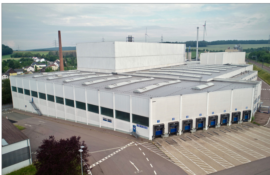
Blick von Süden auf die leer stehende Fertigungshalle der Laminate Park GmbH & Co. KG im zentralen Teilbereich des Plangebietes; Quelle: Gesellschaft für Wirtschaftsförderung Saar mbH
