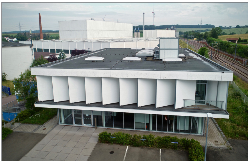
Blick von Süden auf das leer stehende Verwaltungsgebäude der Laminate Park GmbH & Co. KG im südlichen Teilbereich des Plangebietes; Quelle: Gesellschaft für Wirtschaftsförderung Saar mbH
