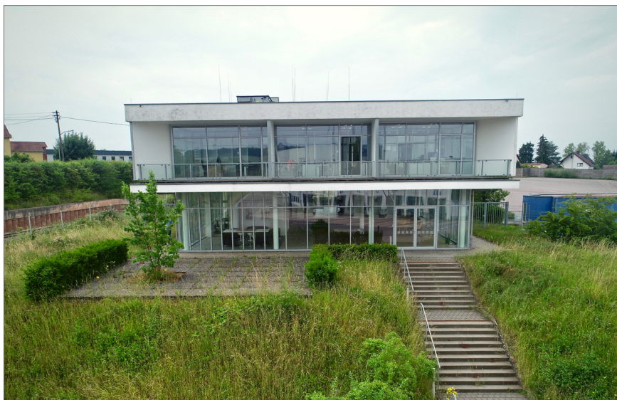
Blick von Norden auf das leer stehende Verwaltungsgebäude der Laminate Park GmbH & Co. KG im südlichen Teilbereich des Plangebietes; Quelle: Gesellschaft für Wirtschaftsförderung Saar mbH
