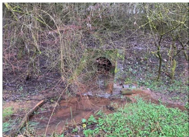
Abbildung 12: Auslauf zur Kreuzbachverrohrung
