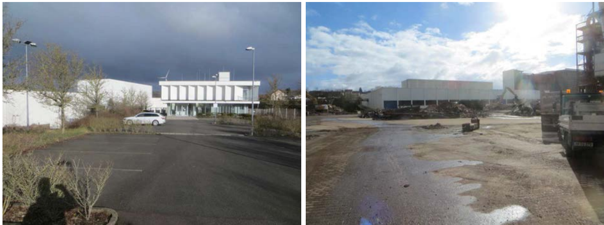
Abb. 4: Eingangsbereich zum Verwaltungsgebäude mit Stellplätzen, Baumpflanzungen und z.T. durchgewachsenen Zierrasenflächen (links) und zentraler Lagerfläche des Laminatpark-Geländes (rechts)
