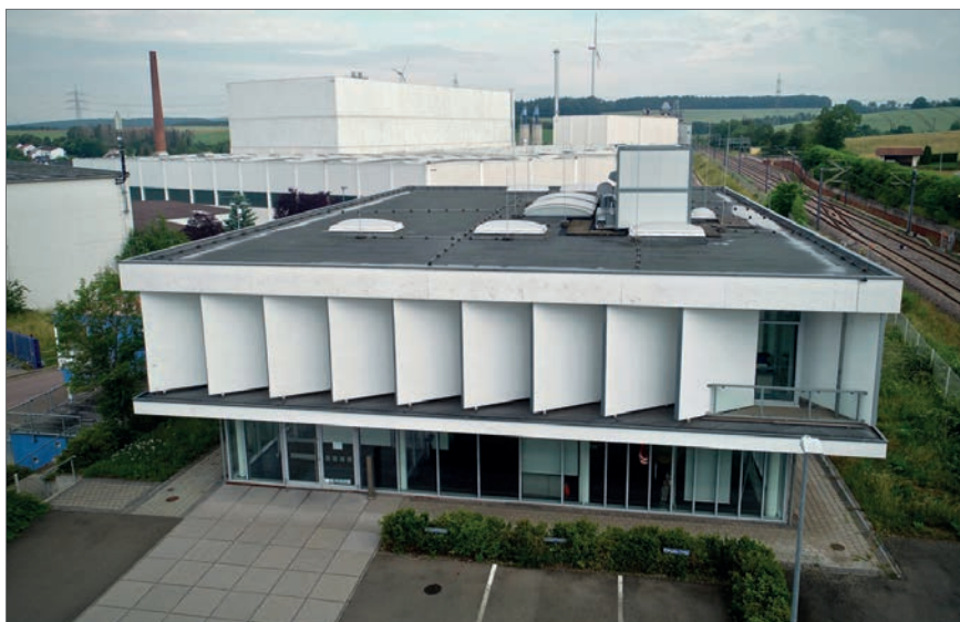
Blick von Süden auf das leer stehende Verwaltungsgebäude der Lamine Park GmbH & Co. KG im südlichen Teilbereich des Plangebietes; Quelle: Gesellschaft für Wirtschaftsförderung Saar mbH
