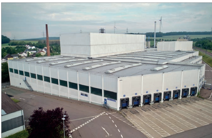
Blick von Süden auf die leer stehende Fertigungshalle der Lamine Park GmbH & Co. KG im zentralen Teilbereich des Plangebietes; Quelle: Gesellschaft für Wirtschaftsförderung Saar mbH
