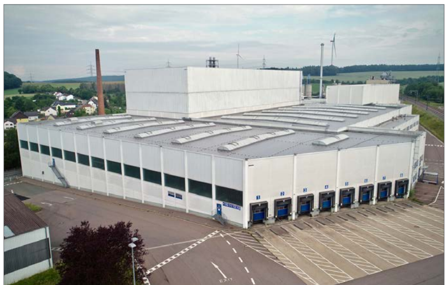
Blick von Süden auf die leer stehende Fertigungshalle der Laminare Park GmbH & Co. KG im zentralen Teilbereich des Plangebietes; Quelle: Gesellschaft für Wirtschaftsförderung Saar mbH
