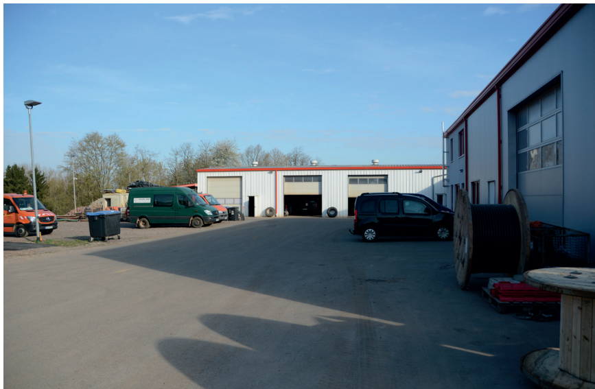
Blick Richtung Nordwesten auf die zwei Bestandsgebäude innerhalb des Plangebietes
