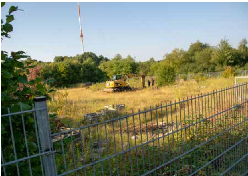
Blick nach Süden über das von Ruderalvegetation und an den Rändern von Gehölzbeständen geprägte Plangebiet
