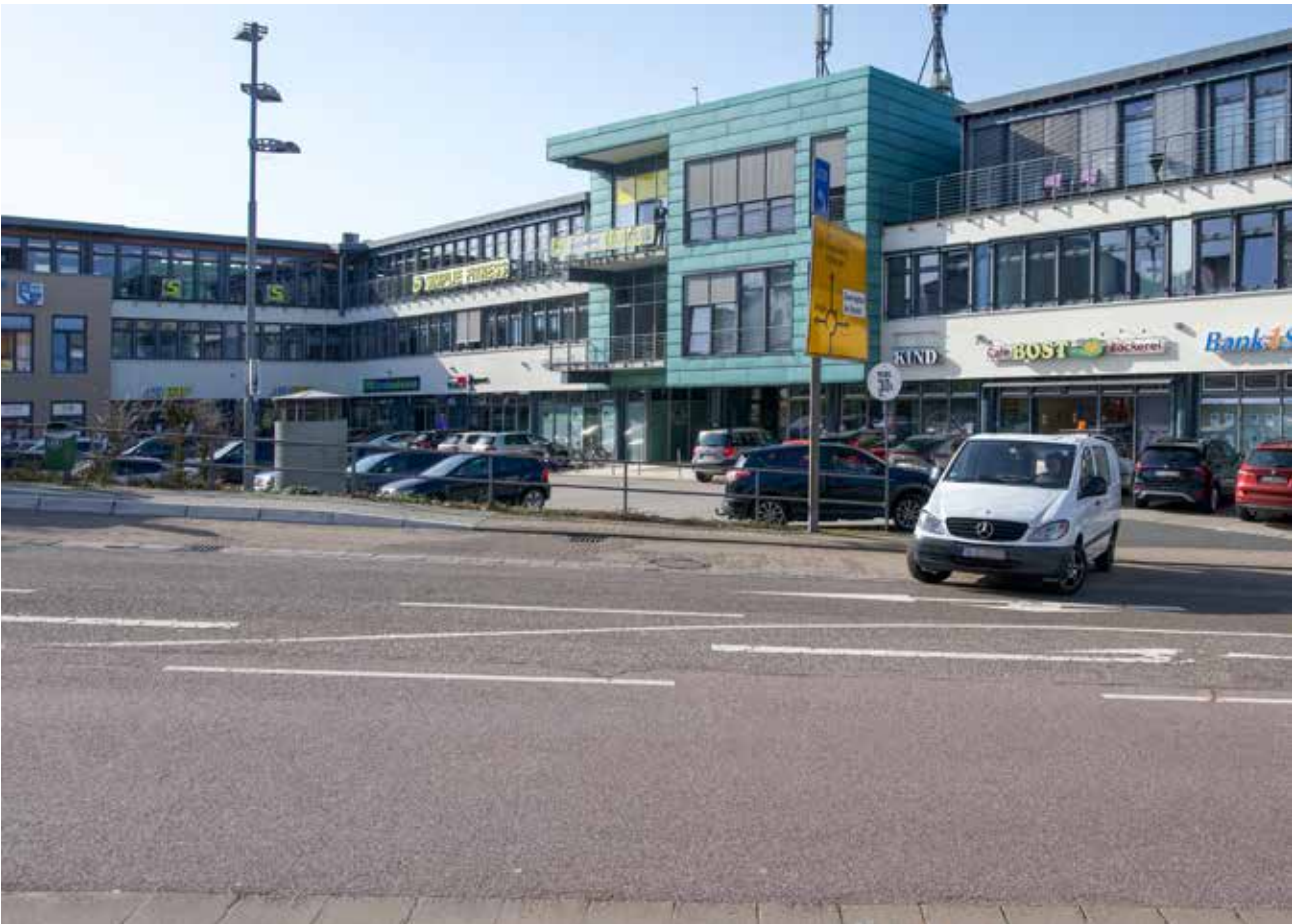
Zur Saarbrücker Straße (B 268) zugewandter Bereich des Fachmarktzentrum „Am Bahnhof“ im Hauptort Heusweiler
