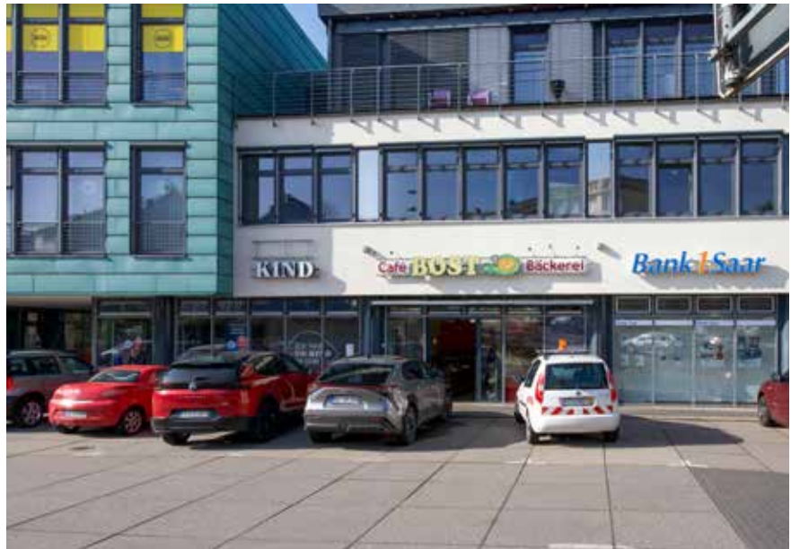
Zur Saarbrücker Straße (B 268) zugewandter Bereich des Fachmarktcenters „Am Bahnhof“ im Hauptort Heusweiler
