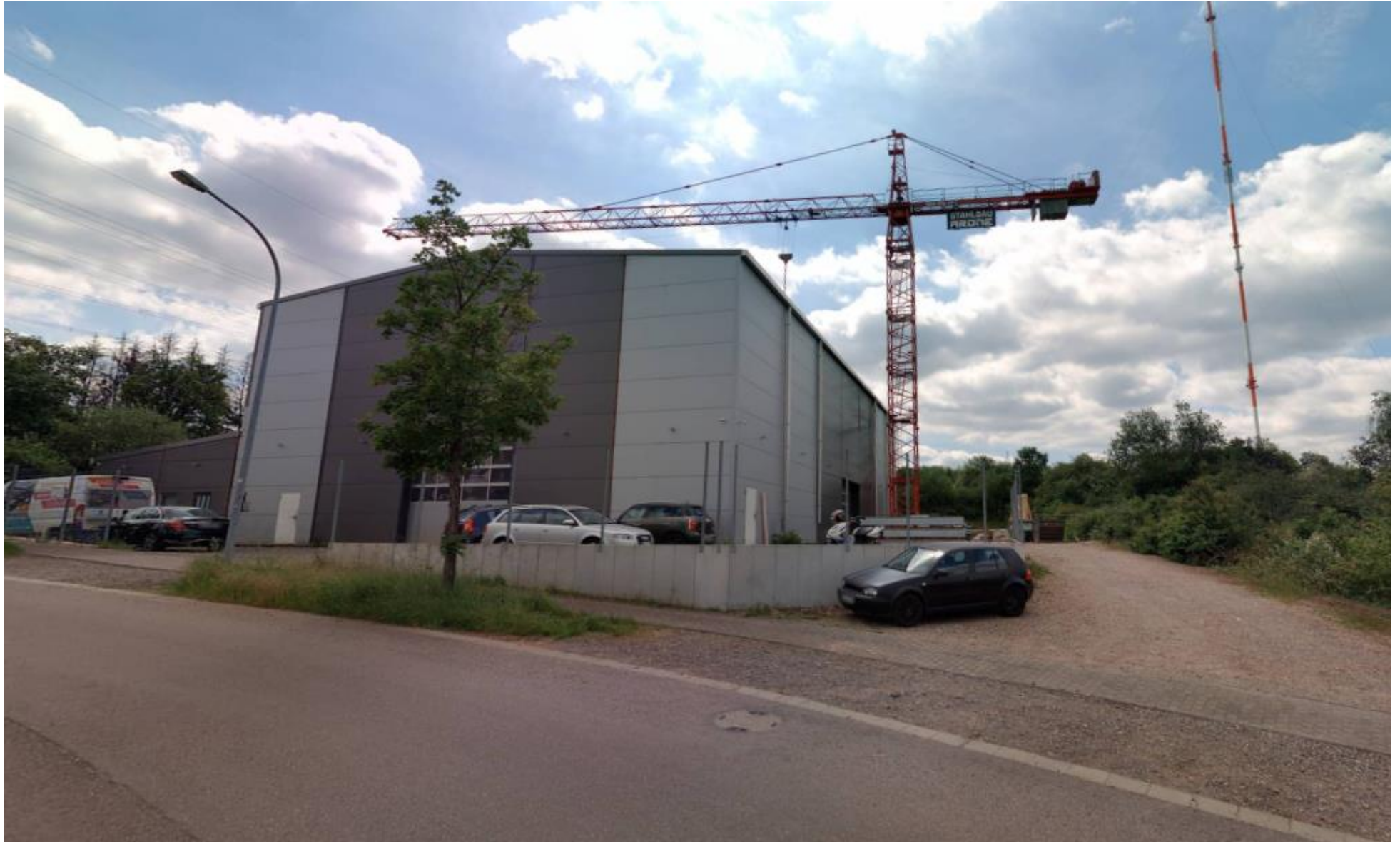
Blick auf die Firma Arone (von der Straße „Auf der Hirtenwies“)
