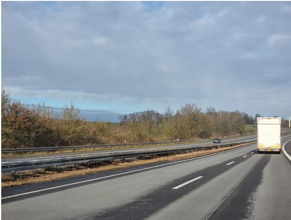
Abbildung 15: Blick von A8 Fahrtrichtung Nordosten, Teilflächen linkerhand teilweise/unterbrochen einsehbar.
