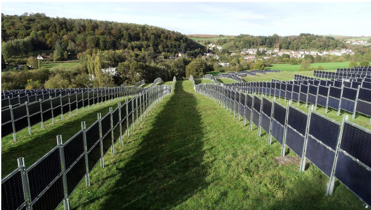
Abbildung 1: Freiflächenanlage mit senkrechten, bifazialen Modulen (Beispiel)
