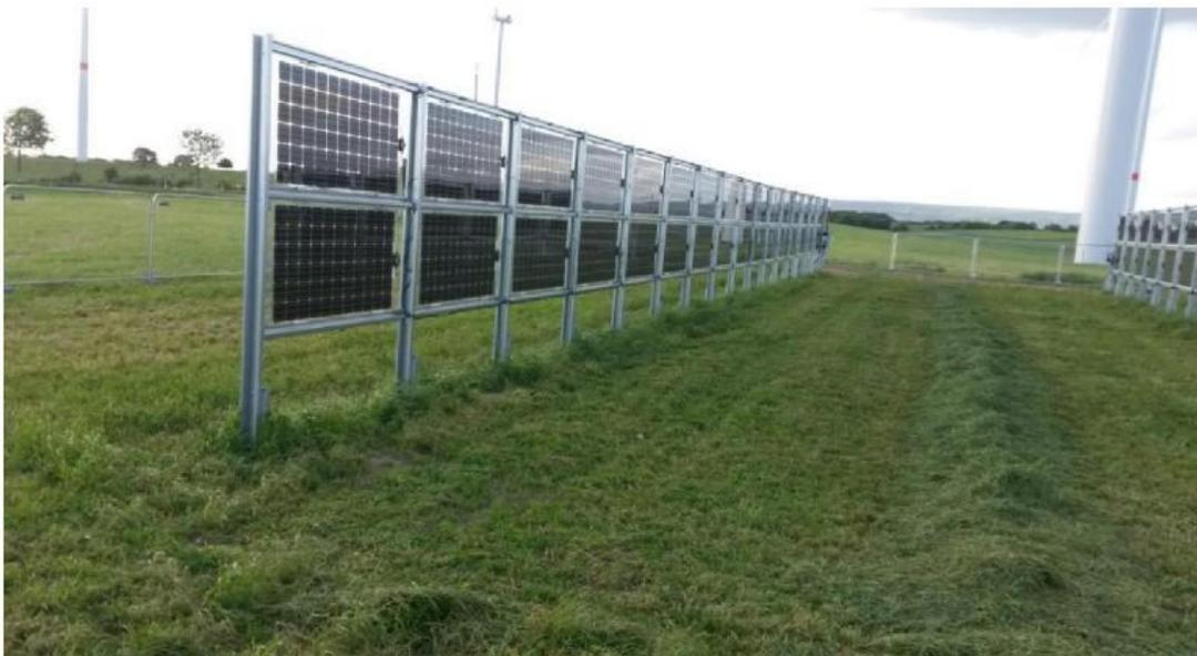
*Abbildung 1: Beispiel für Agri-PV (Pilotanlage)*
