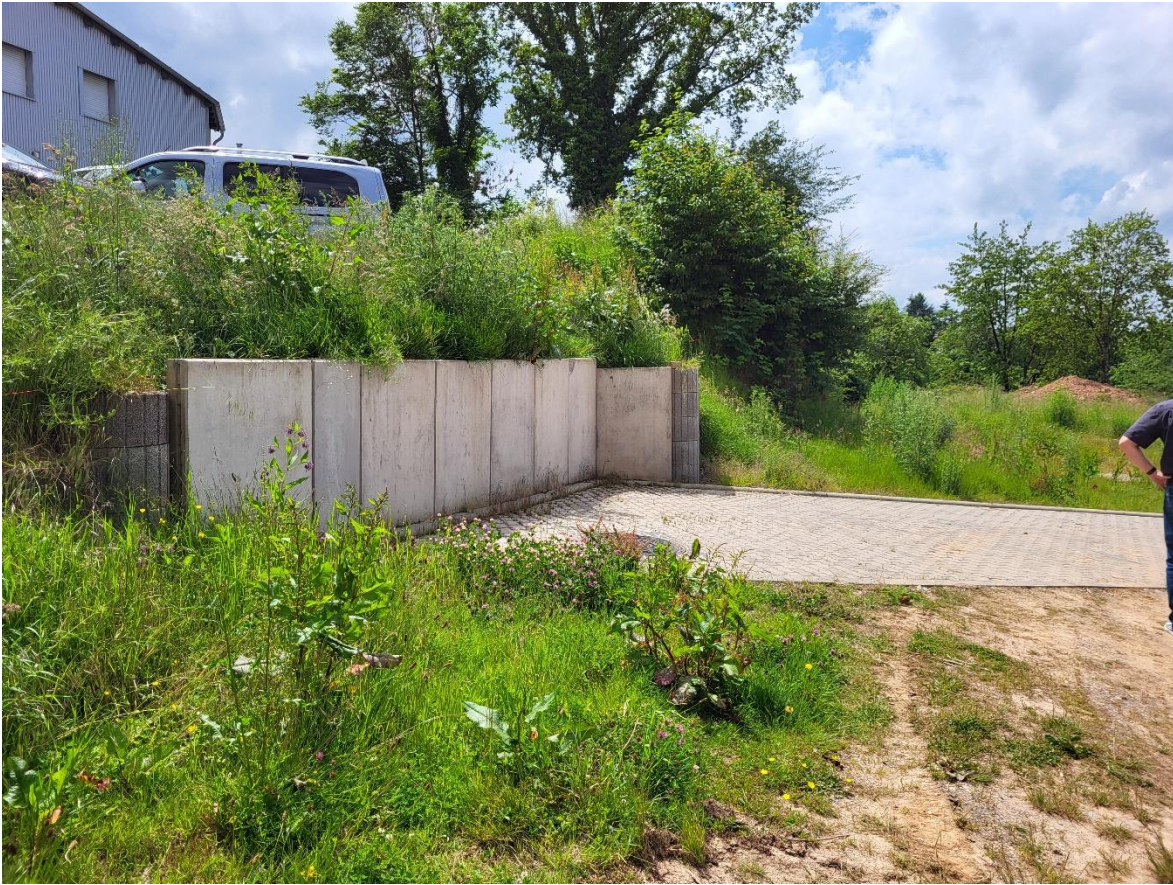
Endpunkt der Straße „In der Neuwies“ mit Sicherung des Höhenunterschiedes
