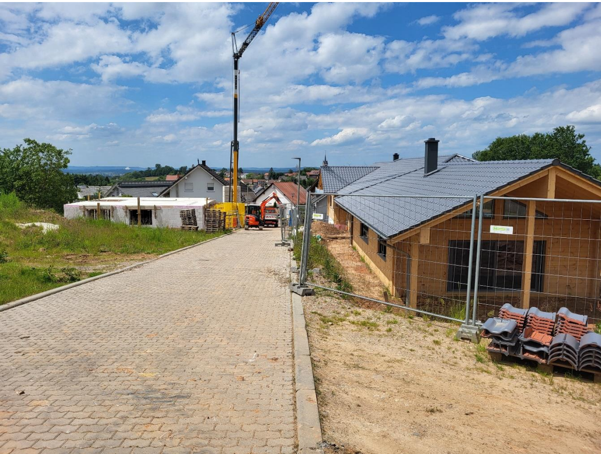
Neubebauung in der Straße „In der Neuwies“ – Flurstück 200/7 rechts und 200/5 im Bau neben Kran
